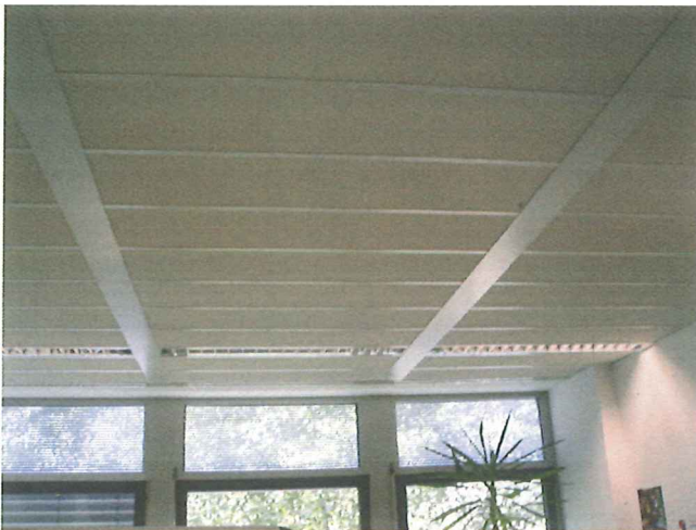
Bild 2: Deckenansicht eines Büros
