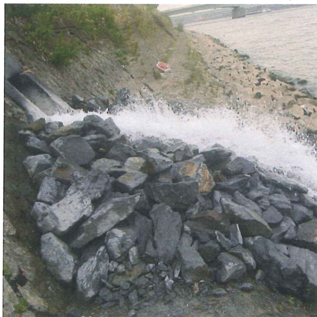
Bild 8: Einleitbauwerk am Rheinufer
